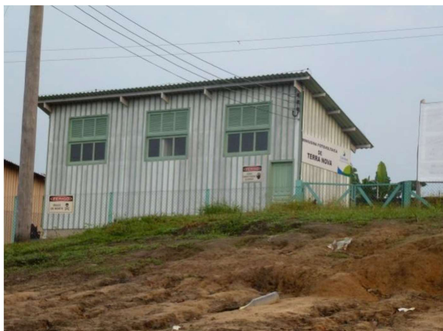
FIGURA 39 – CENTRO DE CONTROLE DA MINI-USINA
