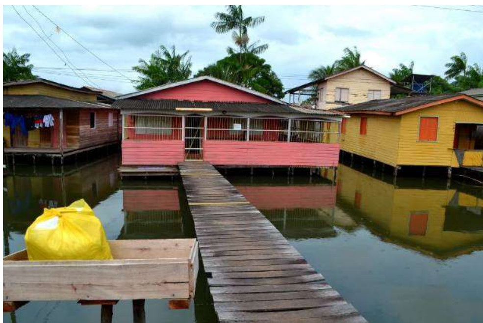
FIGURA 25 - PALAFITA NA ÁREA DE RESSACA NA 11° AV. DO BAIRRO CONGÓS, MACAPÁ-AP
