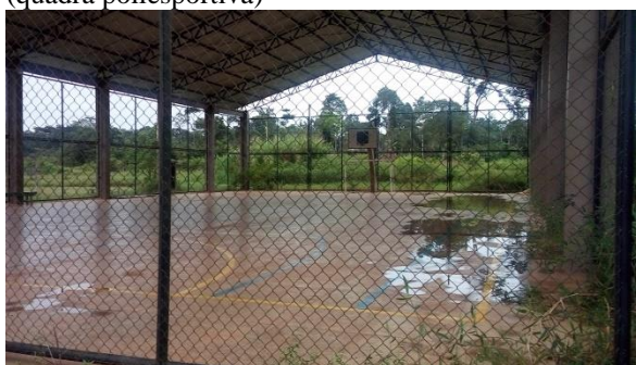
Foto 34 – Escola Família da Perimetral Norte (quadra poliesportiva)
