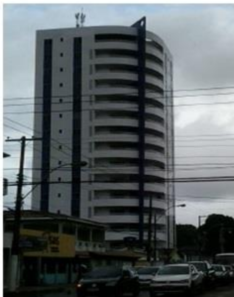
Foto 07: Royal Residence. Fonte: Trabalho de Campo, 2015.
