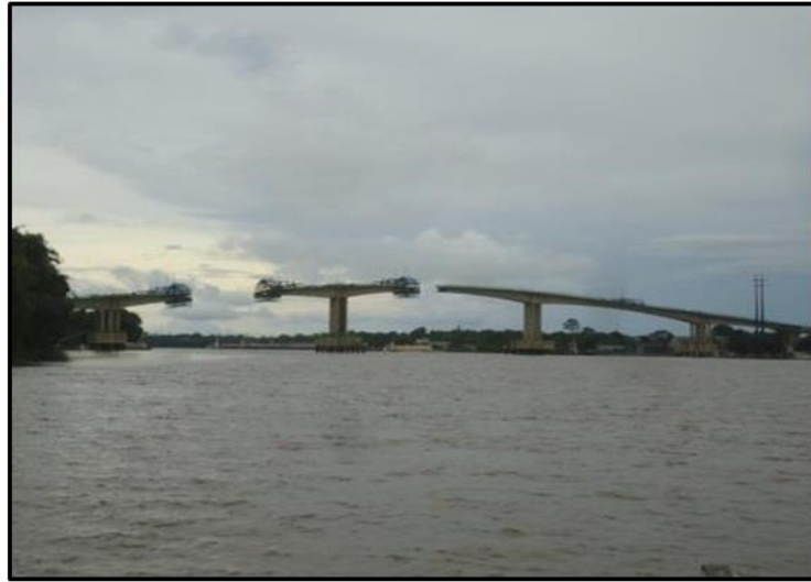
Foto 27: Obra de Construção da ponte sobre o rio Matapi. Fonte: Trabalho de campo, 2015.
