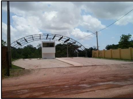
Foto 19: Entrada do “Condomínio de Chácaras Lagoa Azul.
