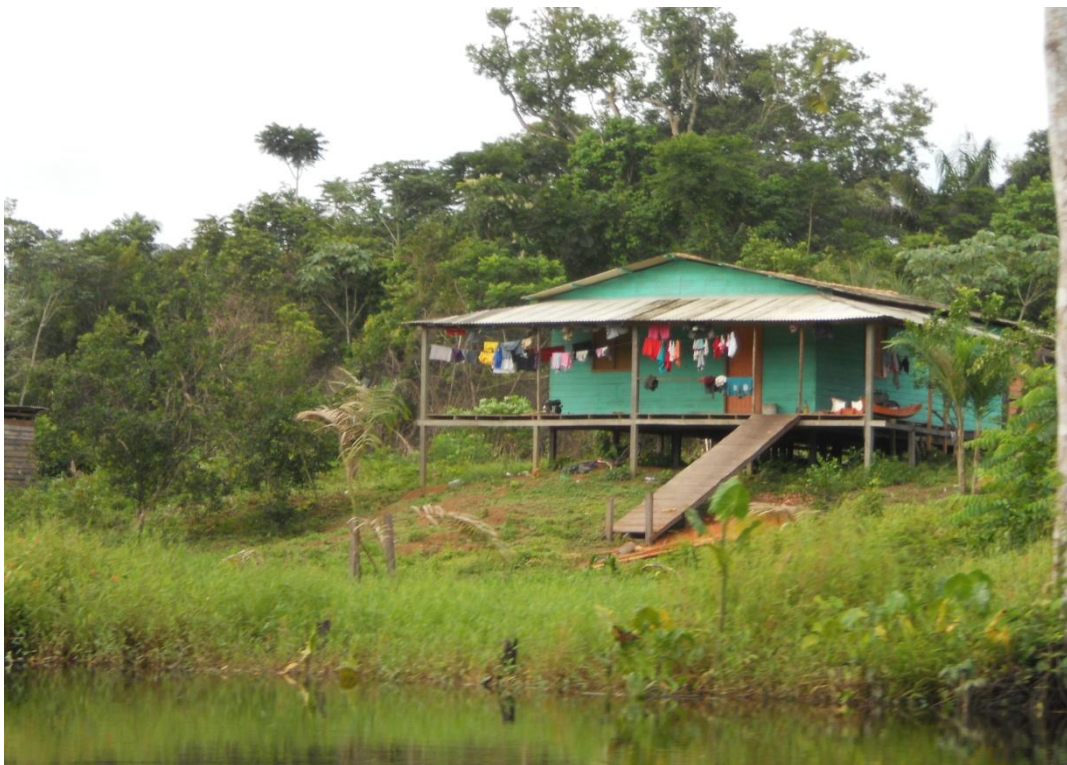
Foto 01 – Vista da casa construída em terra firme na margem de rio Preto com recurso do crédito habitação do programa de reforma agrária.
