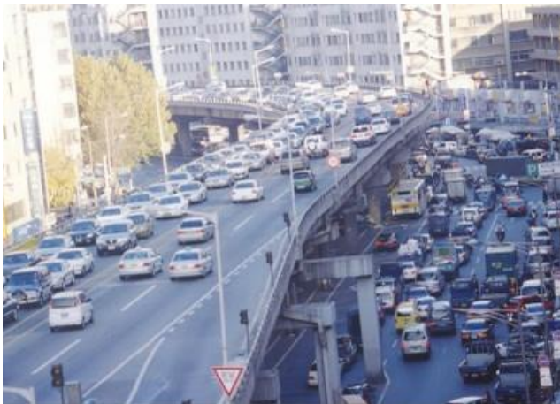
Figura 13 -Viaduto e avenida sobre o Rio Cheong Qye Cheon.
