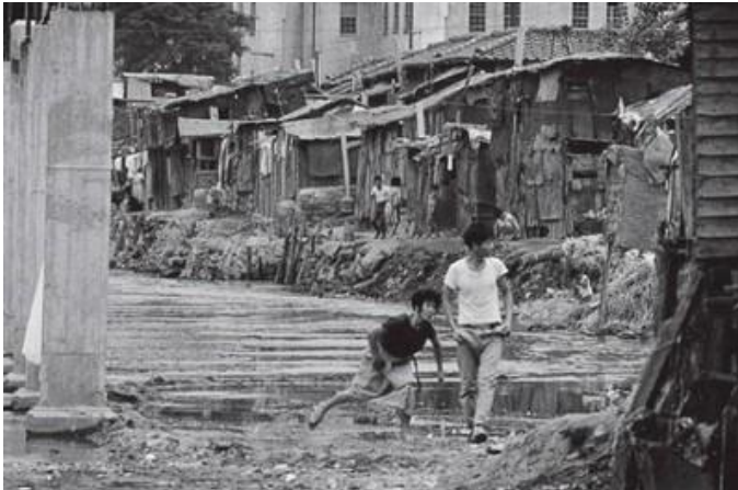
Figura 12 -Ocupação informal às margens do Rio Cheong Qye Cheon.
