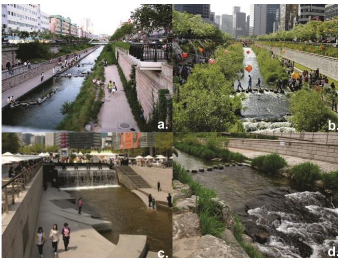
Figura 15 -Tomadas gerais do projetodo Rio Cheong Gye Cheon (a. calçadão, b. tratamento ambiental e paisagístico, c. tratamento paisagístico d. leito do rio).
