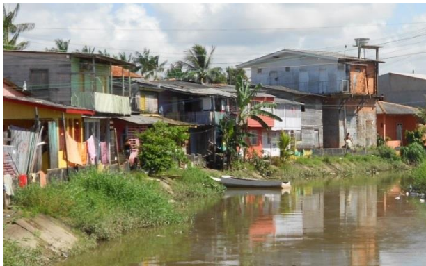
Figura 178 - Ocupações irregulares na entrada do Canal do Igarapé das Mulheres, em Macapá-ap.
