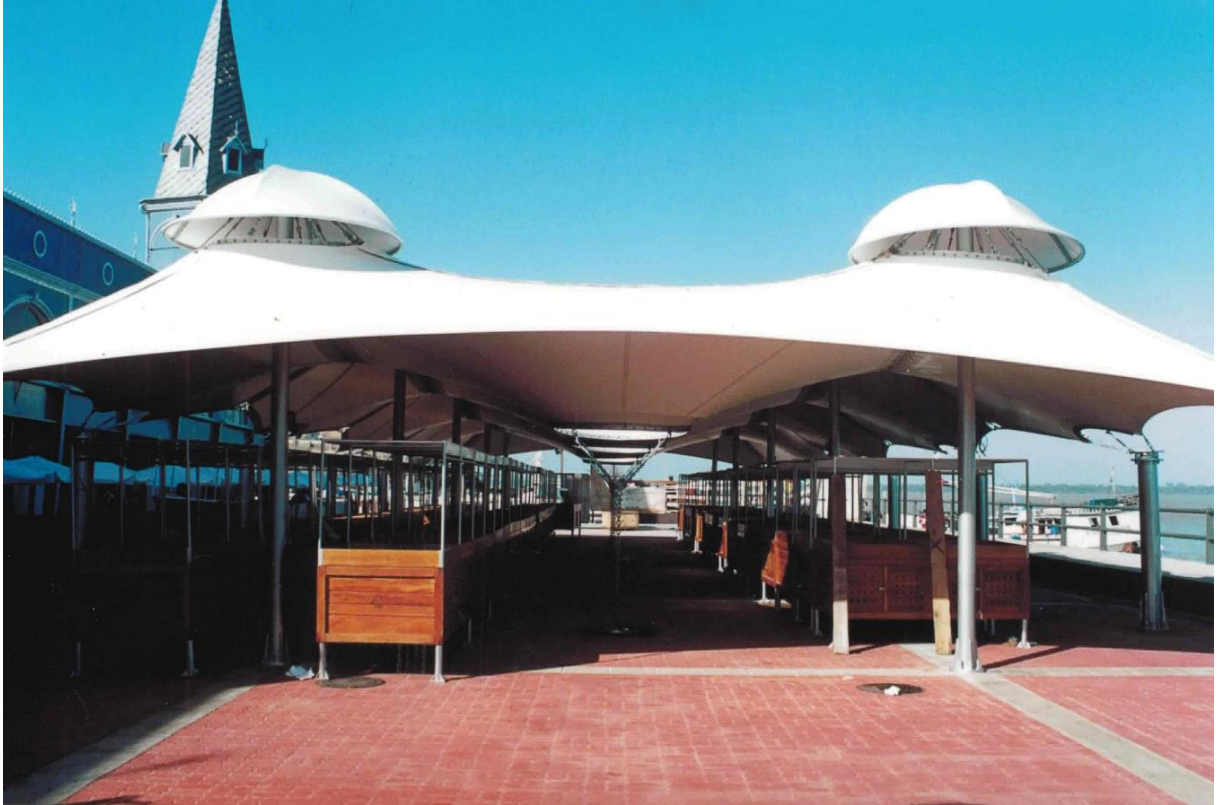
Figura 35 - Cobertura tensionada do Mercado do Ver-o-peso, Belém-PA.
