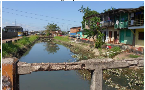
Figura 18 - Ocupação informal, esgoto sanitário improvisado e falta de manutenção nas margens do Canal do Igarapé das Mulheres.
