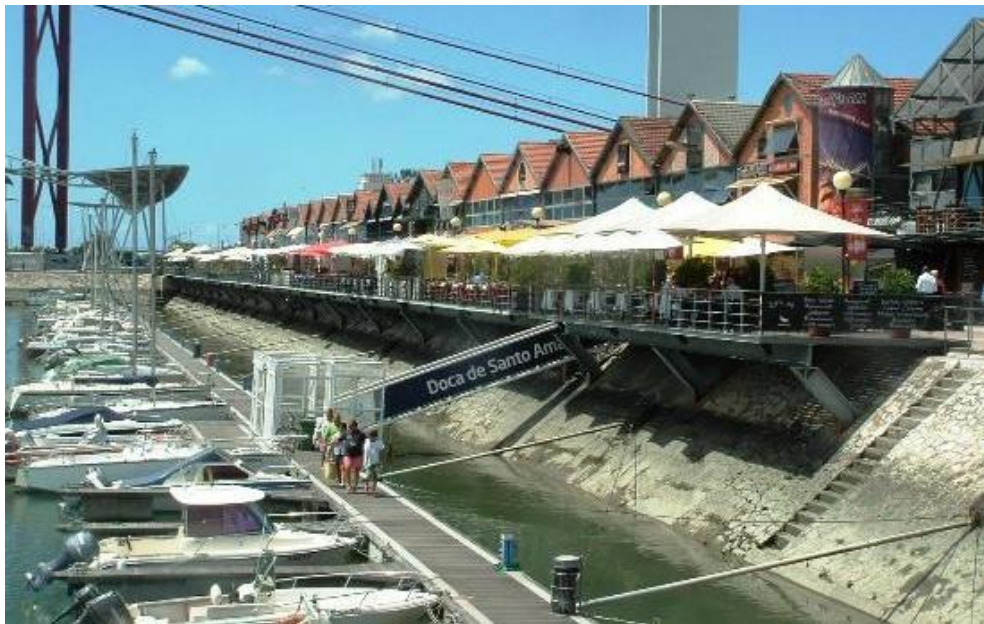
Figura 54 – Passadiços Flutuantes da Doca do Santo Amaro, em Lisboa, Portugal.
