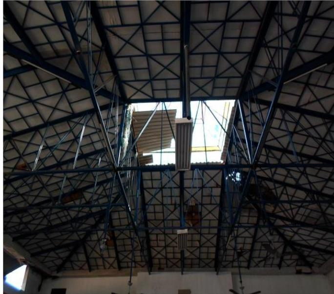
Fig. 28: Estrutura metálica para cobrir a área utilizada pela boate.
