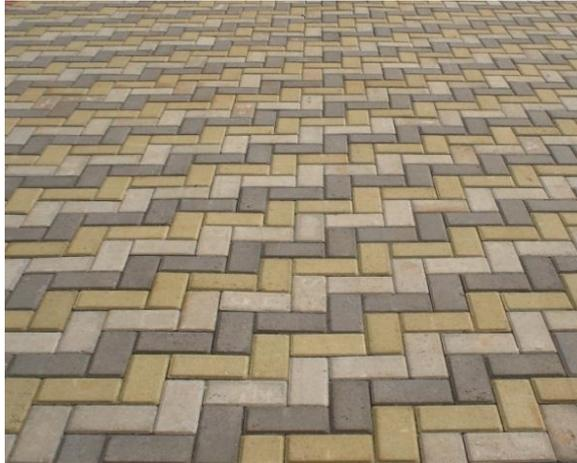
Fig. 103: Piso intertravado de concreto, na disposição em zigue-zague
