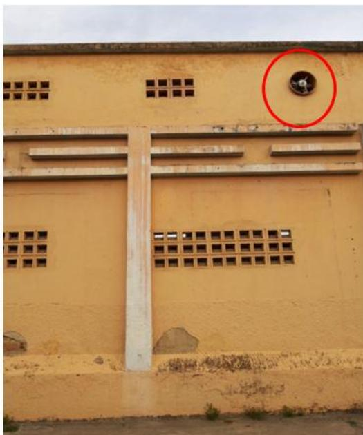
Fig. 55: Ventilação instalada na platibanda.
