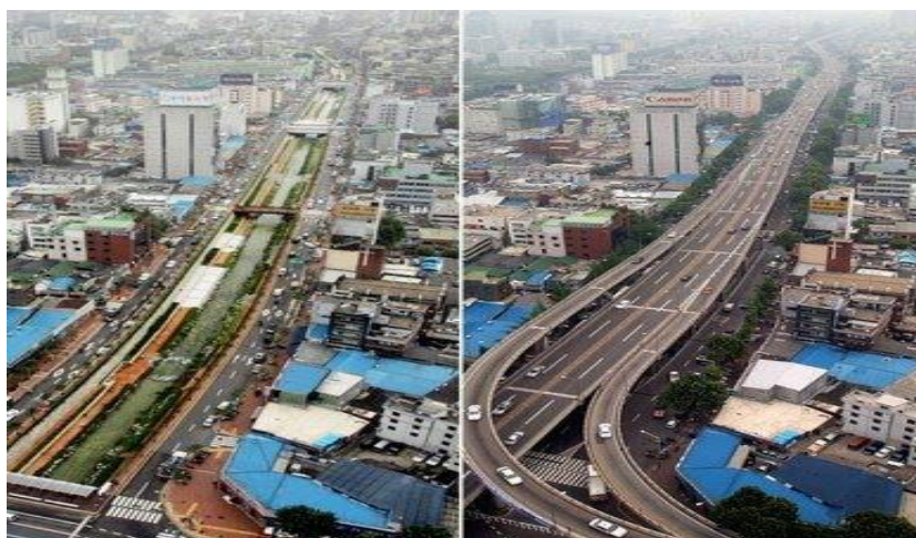
Figura 22: Imagem de parte do canal da cidade de Cheonggyecheon em Seul mostrando na primeira cena o canal restaurado e na segunda o mesmo antes da implantação do projeto.
