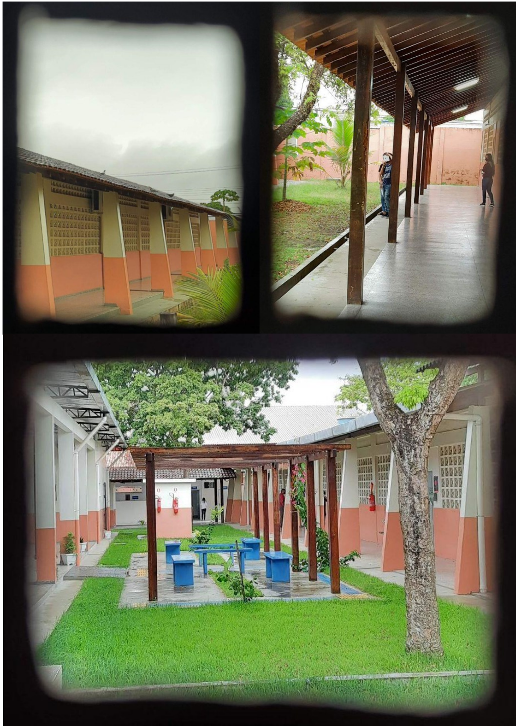
Imagem 6 – Estruturas em diferentes áreas da escola
