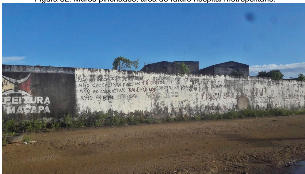
Figura 32: Muros pinchados, área do futuro hospital metropolitano.
