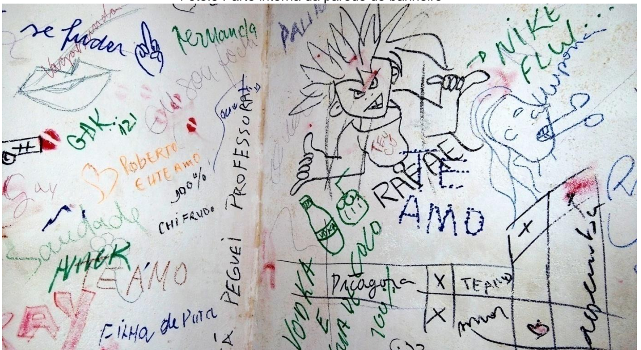
Foto.9 Parte interna da parede do banheiro
