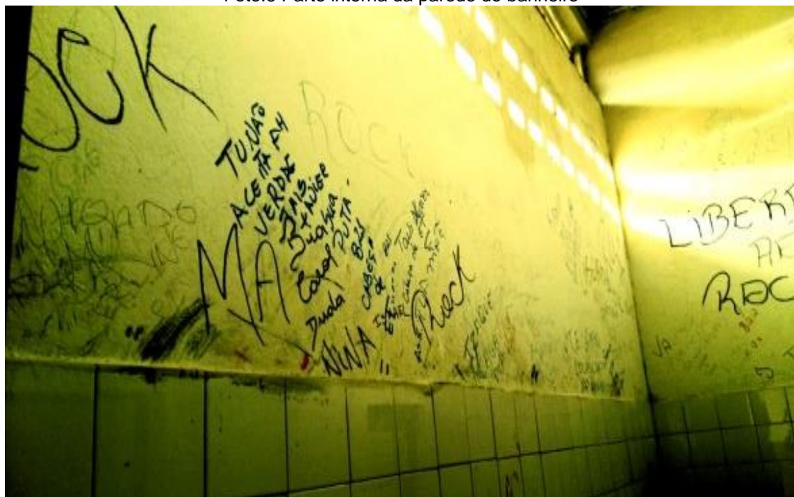
Foto.6 Parte interna da parede do banheiro
