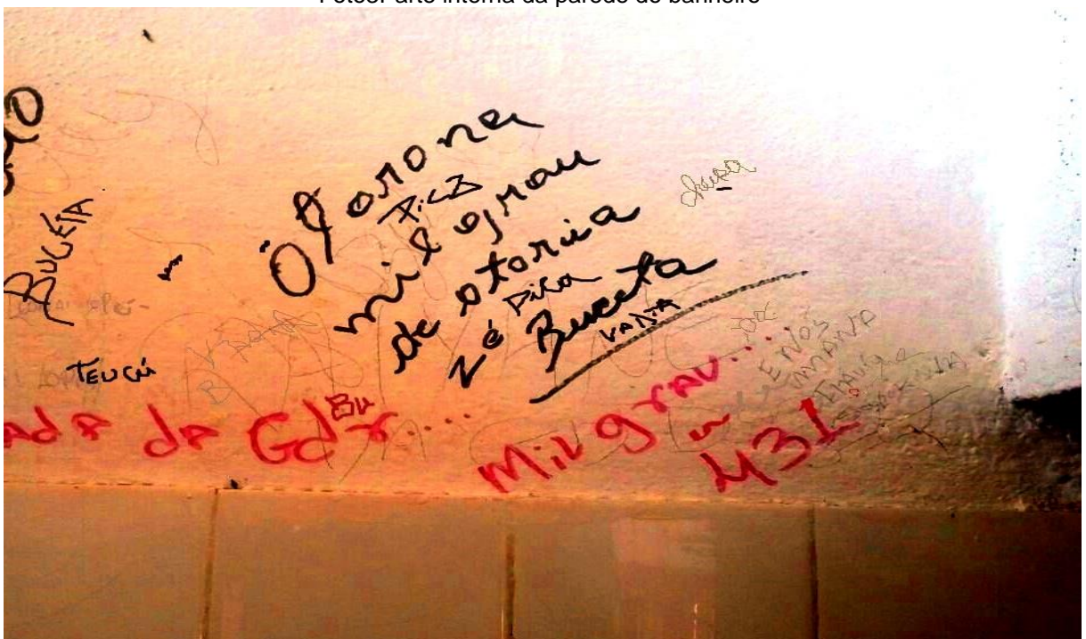
Foto3Parte interna da parede do banheiro
