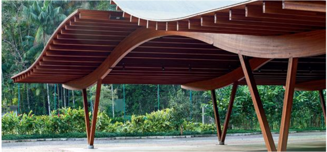
FIGURA 3- COBERTURA DO PAVILHÃO DE IPORANGA
