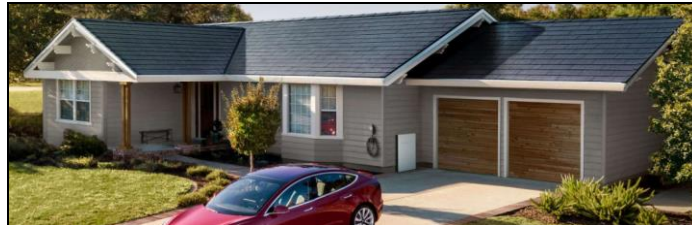
Figura 67 e 68 – Cobertura fotovoltaica Tesla e utilizada ao projeto, respectivamente.
