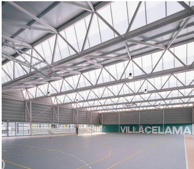
Figura 54 – Iluminação zenital do pavilhão poliesportivo Villacelama.
