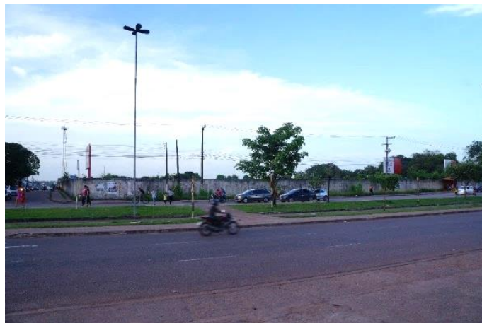
Figura 28 – Acesso Sul, Rodovia Perimetral Norte.
