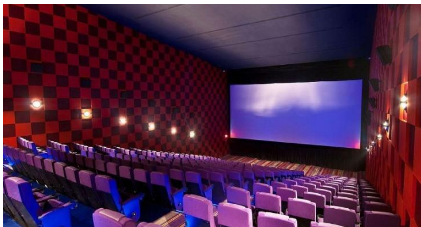
Figura 58 – Uso de espuma acústica em sala de cinema.
