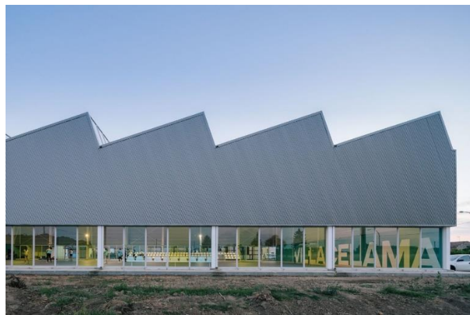
Figura 49 – Fachada do pavilhão poliesportivo Villacelama.
