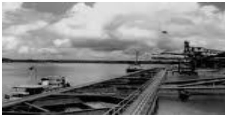
Figura0 3: Construção do porto flutuante de Santana/AP.
