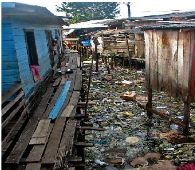
Figura 2 - Passarela de acesso às residências no Bairro Malvinas
