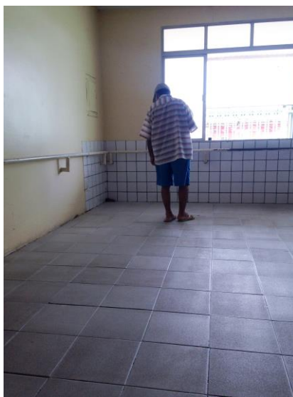
Figura 29 - Vista do piso e esquadrias
