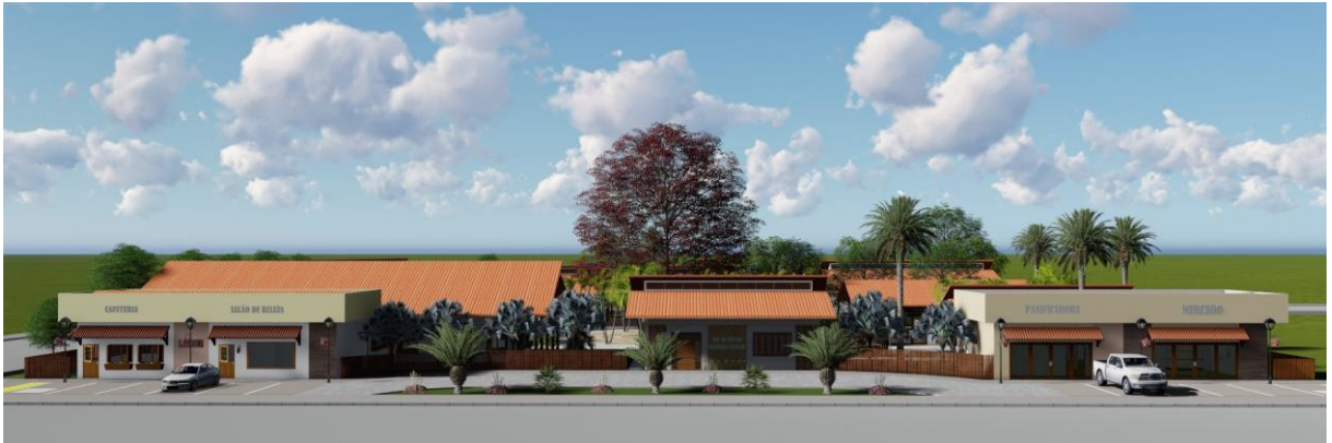
Figura 68 – V1: Vista geral do conjunto pela Av. Ernestino Borges
