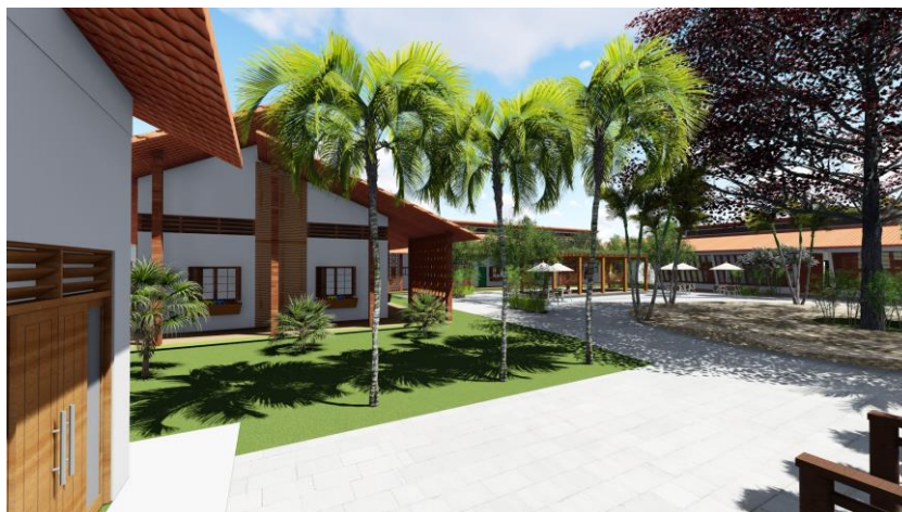
Figura 73 – V6: Vista do pátio central e bloco de habitação
