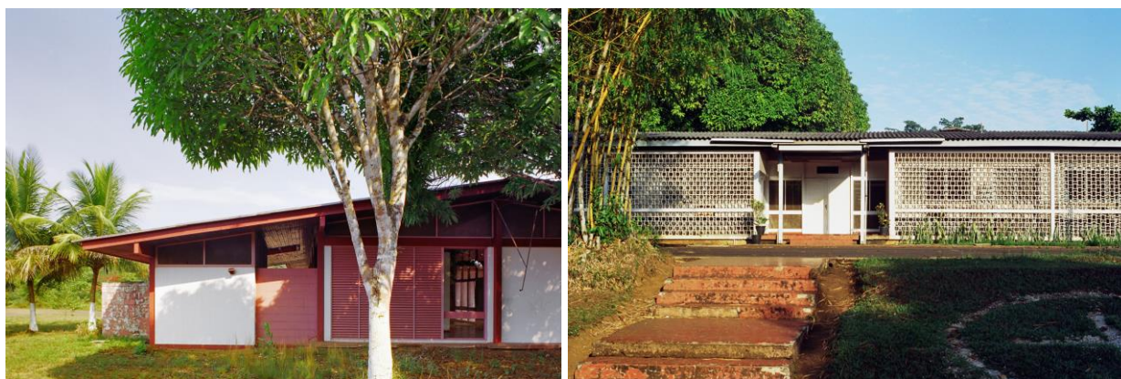
Figura 50 – Residências na Vila de Serra do Navio
