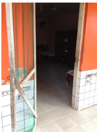
Figura 30 - Vista da porta do dormitório
