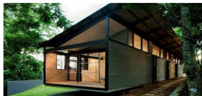
Figura 10: a utilização das telhas termoacústica
