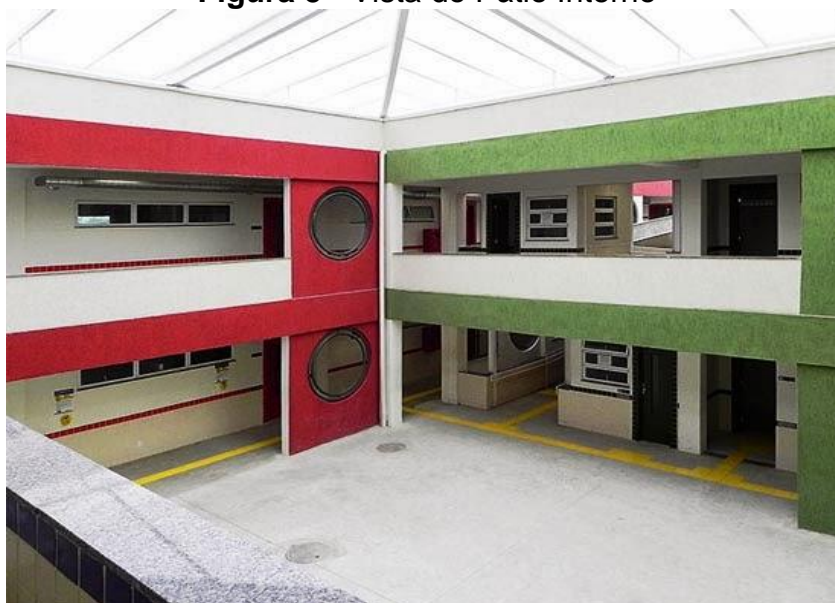
Figura 5 - Vista do Pátio Interno
