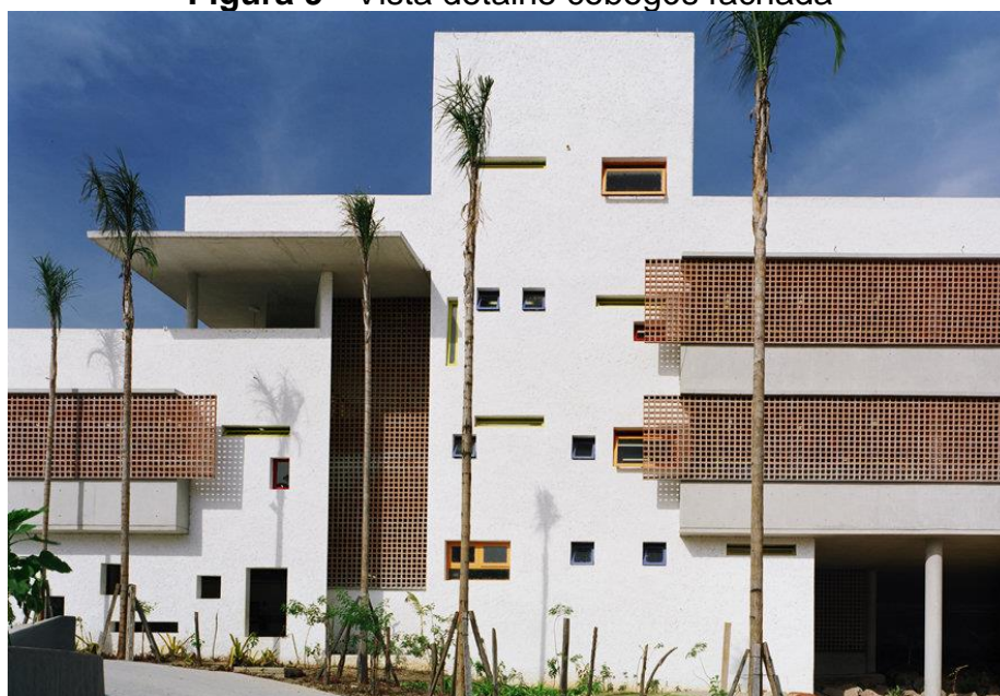
Figura 9 - Vista detalhe cobogós fachada
