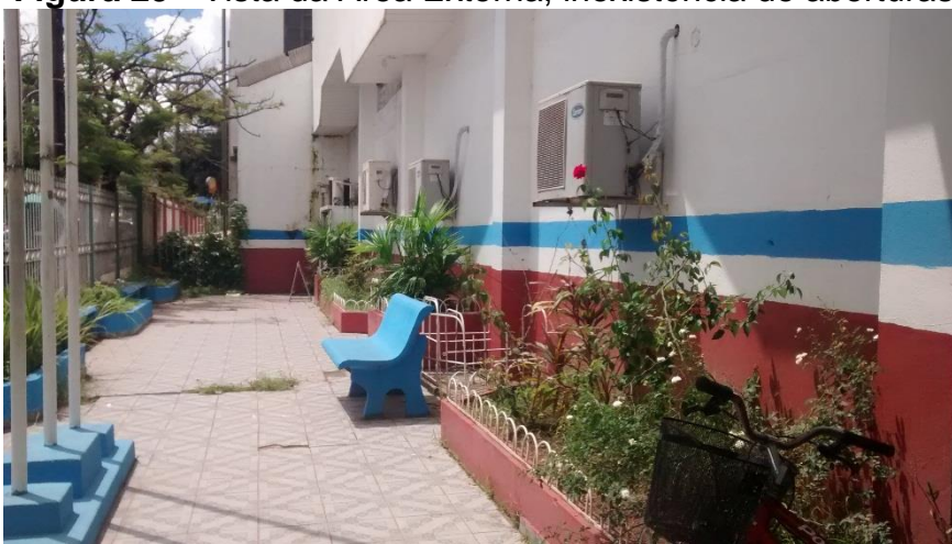
Figura 29 - Vista da Área Externa, inexistência de aberturas
