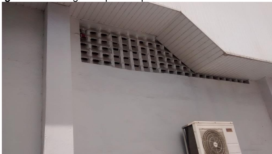
Figura 30 - Cobogós na parte superior das laterais das fachadas
