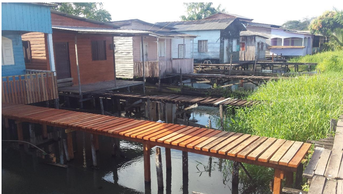
Figura 8 - Casas em Palafita sobre área alagada na Ressaca Chico Dias.
