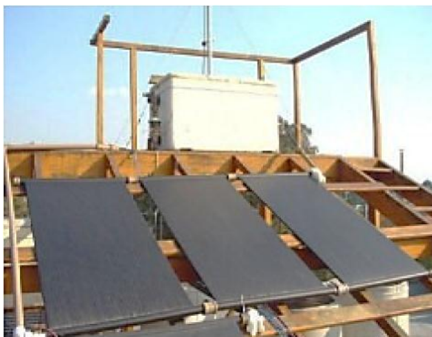
Figura 27 - Estrutura do ASBC montada.
