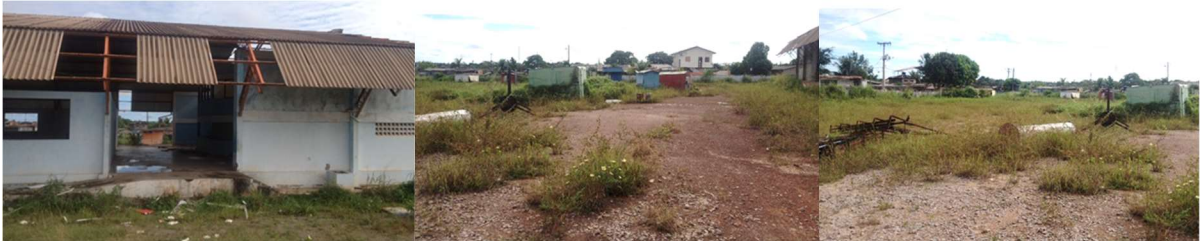
Figura 31, 32 e 33 - Subprefeitura com trailers abandonados em estado de ferrugem
