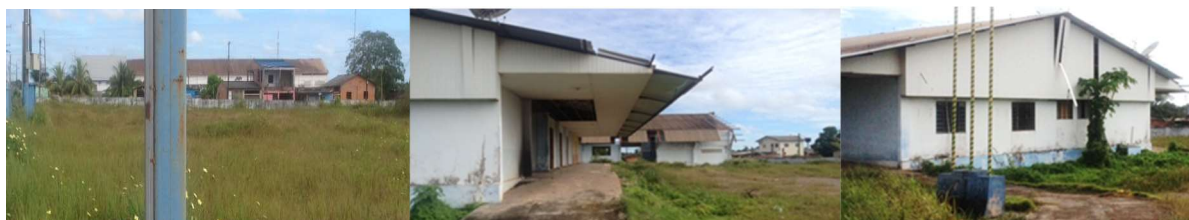
Figura 28, 29, 30 - Entrada da SubPrefeitura da Zona Norte coberta de mato.
